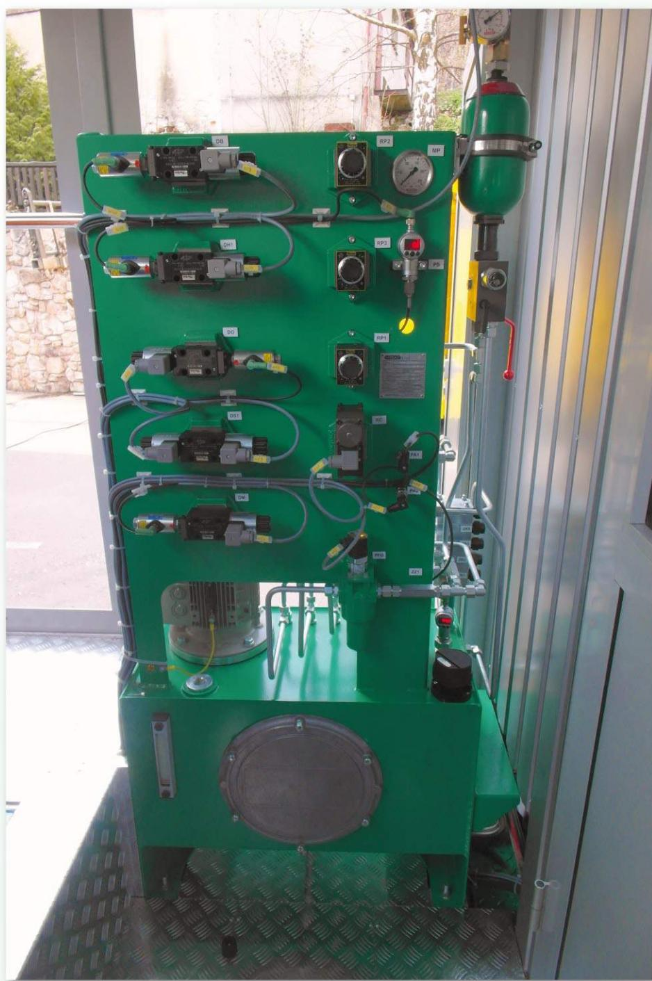
Питание подъемной машины делает возможным подключение к шахтной сети 3x 500VAC, благодаря предохранителю-разъединителю.
