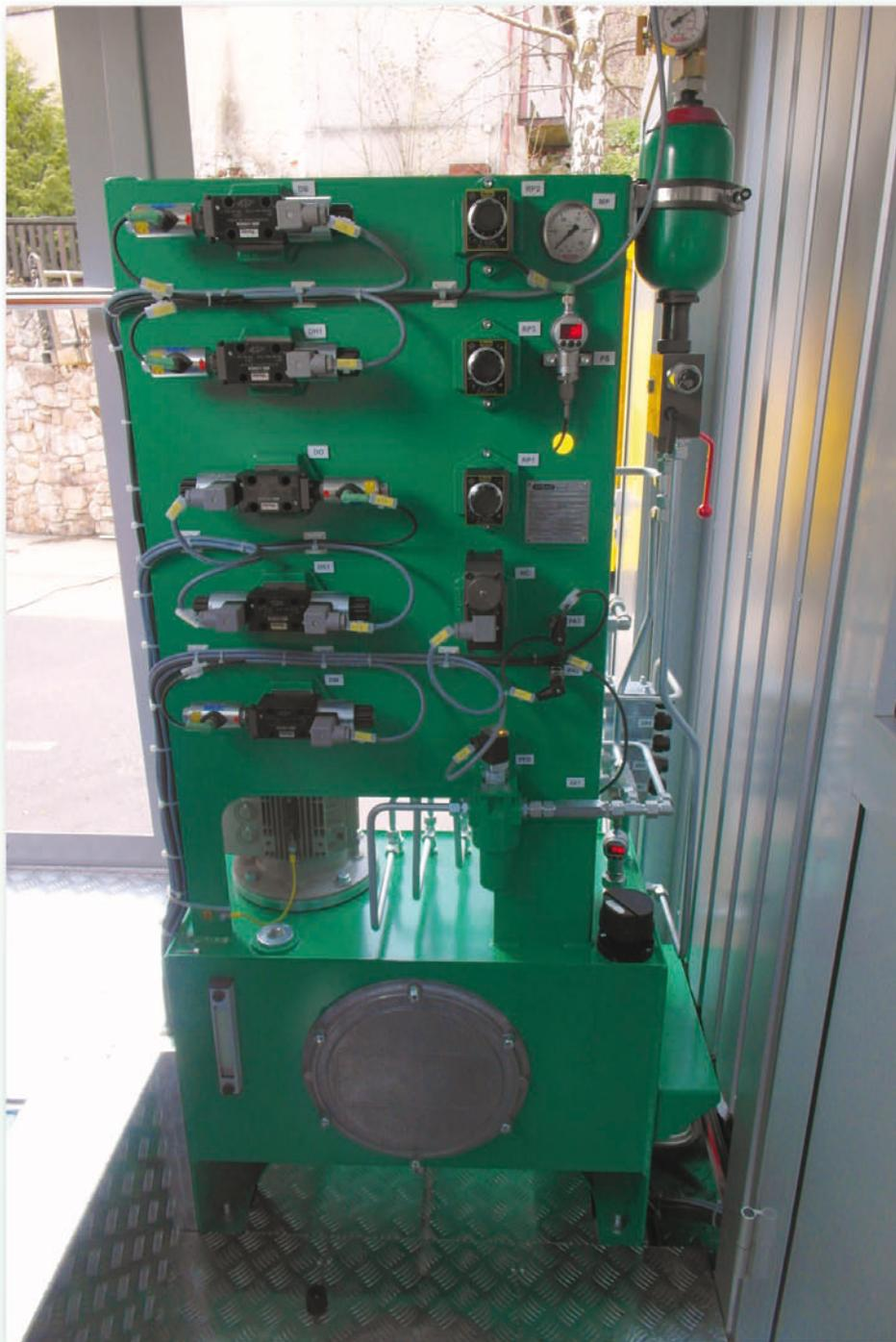
El elevador está alimentado por corriente continua de 3x500VAC, conectado a través de un interruptor con fusible.
